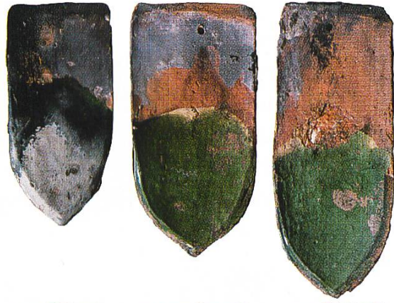
Abb. 25, 26 Ravensburg, Grüner Turm, Reparaturziegel 18. Jahrhundert, Kurz-, Normal- und Langziegel im Vergleich, Aufsicht und Untersicht.
