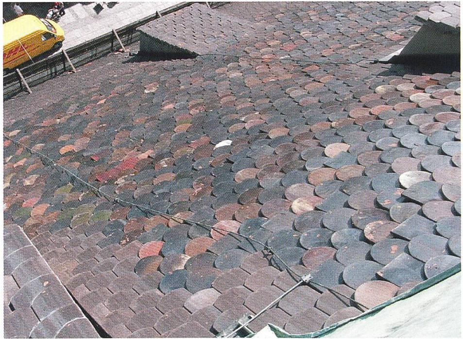
In der zweiten Hälfte des 19. Jahrhunderts verringerte sich die Dicke der Ziegel erheblich und betrug zumeist 1,0 bis 1,4 cm. Dieser Umstand steht mit Sicherheit in Zusammenhang mit der Liberalisierung der Bauordnung.<sup>17</sup>
