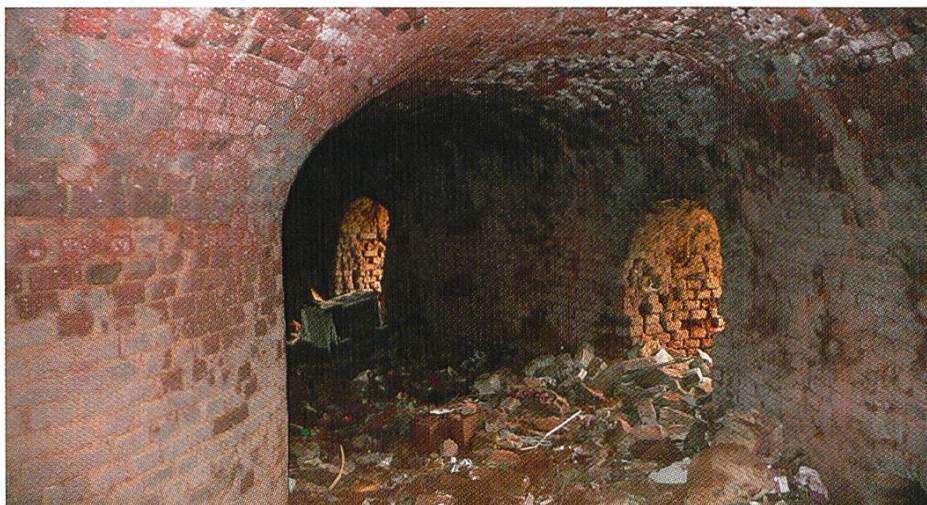
Leoben in der Obersteiermark A, ehemalige Ziegelei Dörfler: Blick in die Biegung des ovalen Ringofens.
