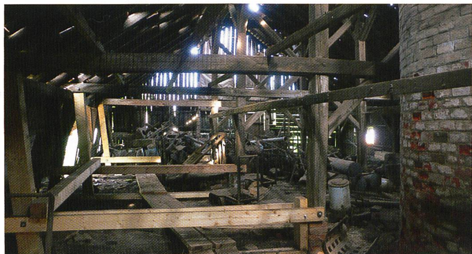
Leoben in der Obersteiermark A, ehemalige Ziegelei Dörfler: Raum mit Gerätschaften über dem Ringofen.
