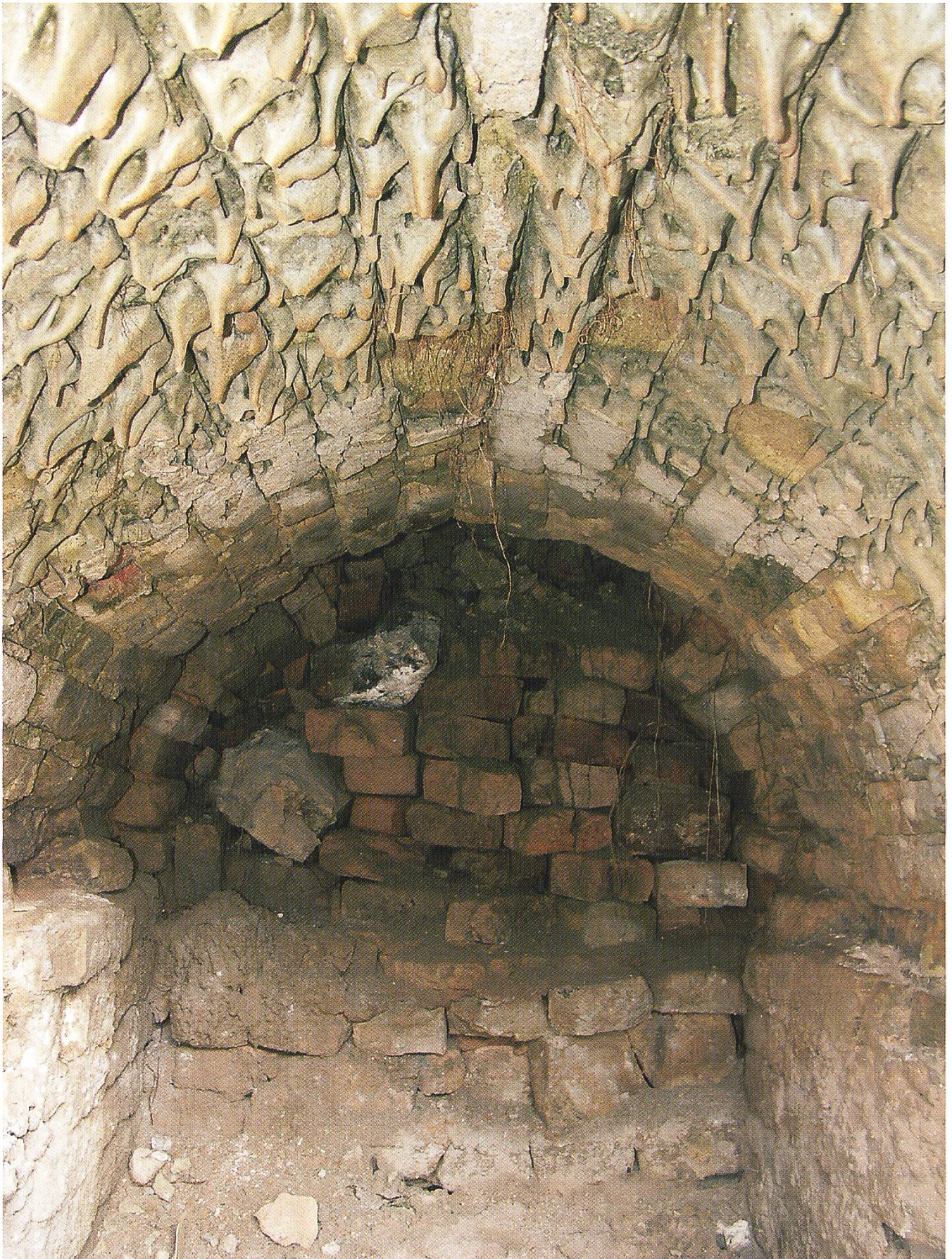
Abb. 5: Schürkanal mit verglasten Ziegeln.
