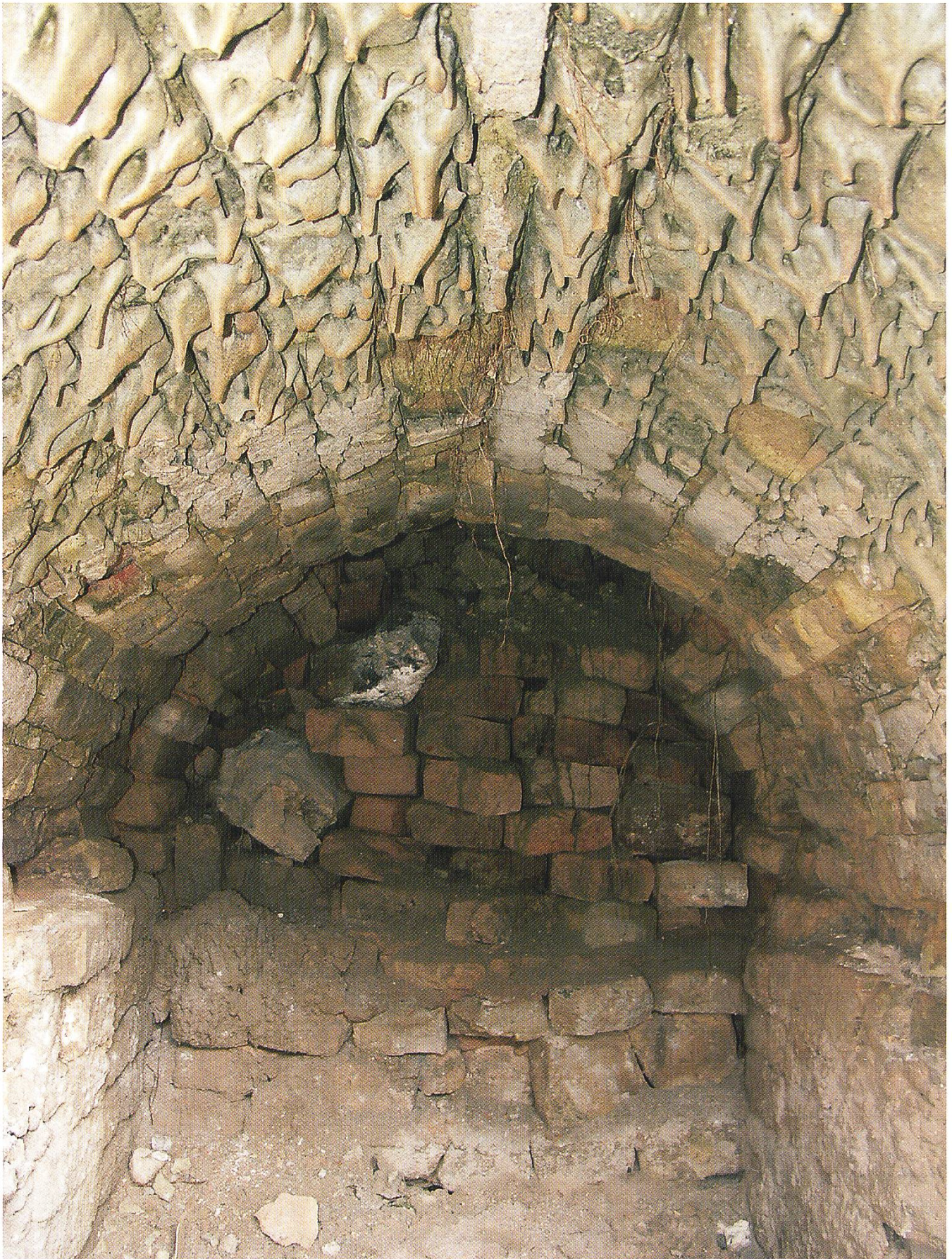
Abb. 5: Schürkanal mit verglasten Ziegeln.
