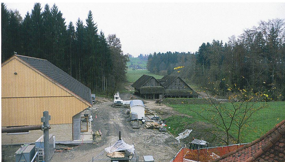
Cham, Zieglerareal: links Neubau, im Hintergrund die alte Ziegelhütte, Blick gegen Süden, am 14. November 2012.
