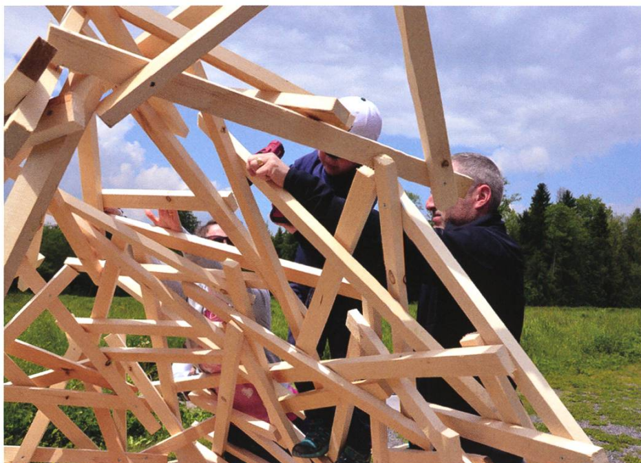
Bauen mit Dachlatten unter der Leitung von Leto und Pia Familienevent.
