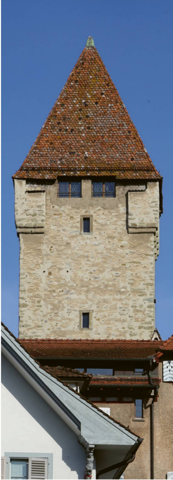
Abb. 17 Luzern, Musegg, Dächliturm. 2012 restauriert. Foto Jürg Goll 2021.
