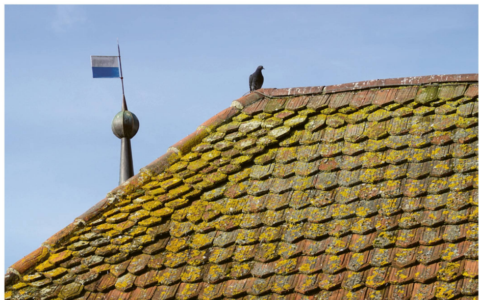
Abb. 4 Luzern, Kapellbrücke. Einfachdeckung sowie First- und Gratkronen nach der Renovation 1994. Foto Jürg Goll, 2021.
