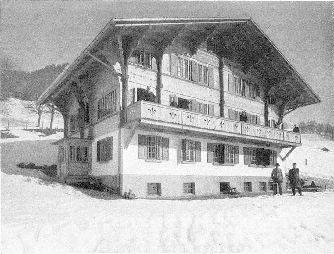
Gesamtansicht des Altersheims Saanen.
