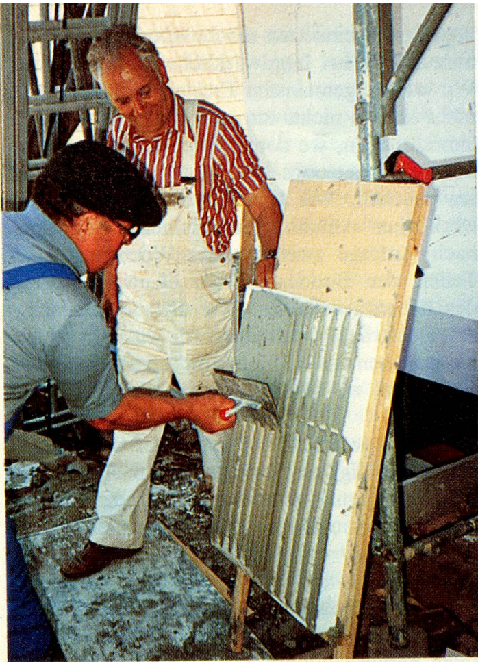
Auftragen der Klebmasse auf die Isolierplatten.
