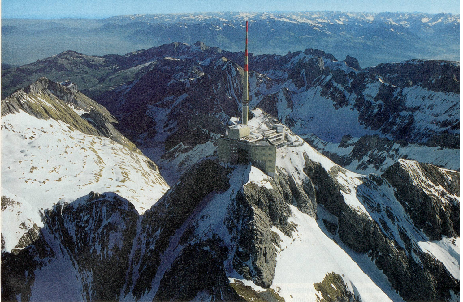
Der Arbeitsplatz auf dem Säntisgipfel mit dem Antennenturm: Natur und Technik kommen auf dem Wetterberg zusammen.
