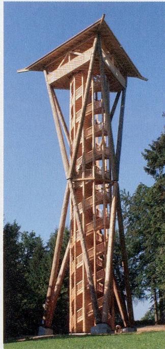
Wils neues Wahrzeichen ist der Turm mit dem grossen Überblick. Die doppelte Wendeltreppe verhindert Gegenverkehr bei Auf- und Abstieg.
