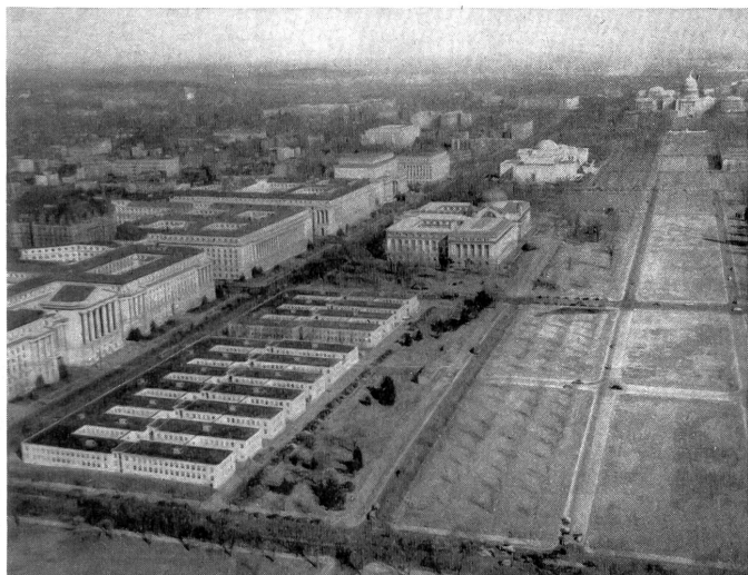
Blick auf einen Teil des Regierungsviertels von Washington, einer Stadt, in der ein besonderes Frauenproblem entstanden ist. Links eine Reihe von Bureauälästen, im Hintergrund das Capitol.
