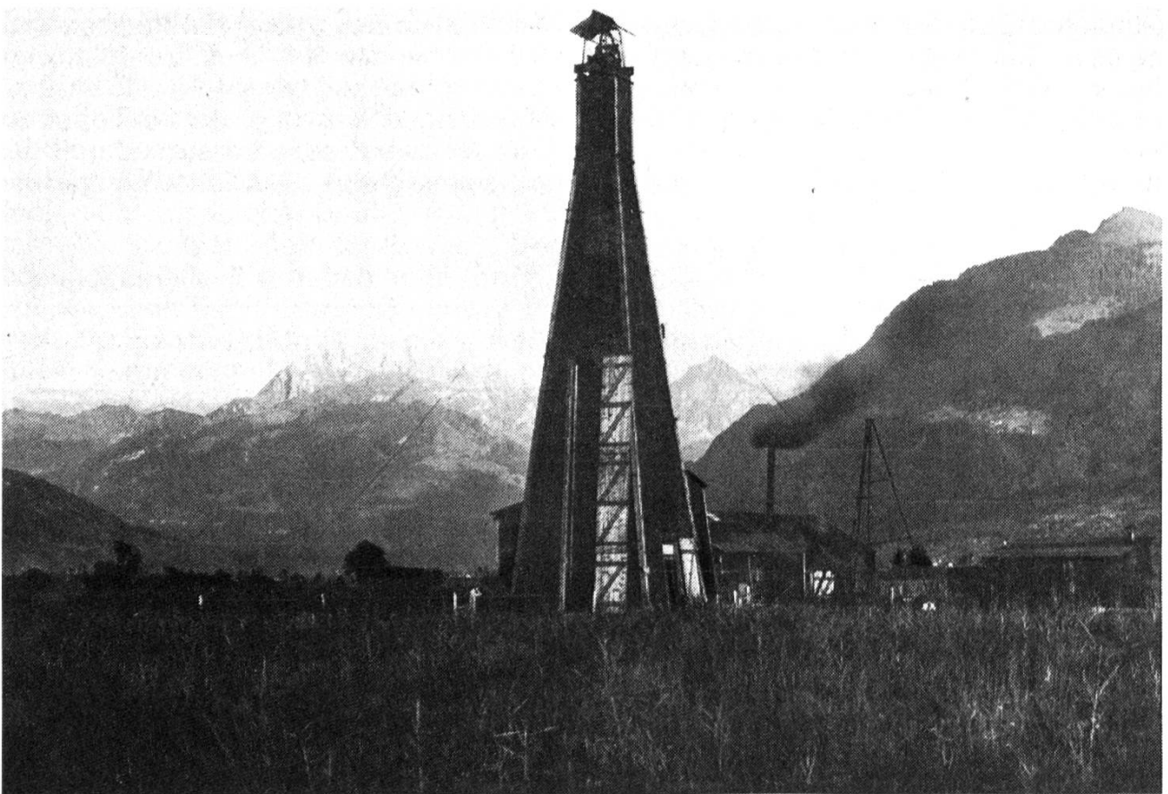
Bohrturm im Riedland: historische Aufnahme aus der Linth-Ebene, die anschaulich macht, weshalb die Bevölkerung die Türme als «Teufelskirchen» bezeichnete.
