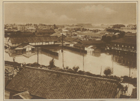
Hochwasserbedingung in Zürich. Die städtische Oberwasserbrücke über den Limmatkanal und die gegenüberliegende Seite des Limmatkanals sind im Vordergrund zu sehen.
