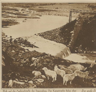
Sicht auf die Ausdehnung des Staumauerwerks. Die Katastrophe forderte über 20 Personen zum Opfer
