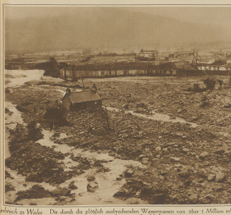
Der große Dammbruch in Wales. Die durch die plötzlich ausbrechenden Wassermassen von über 1 Million m 3 angehäuften großen Verformungen
