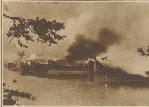
Verdampfung von 11 verpochtenen Kesseln. In Barmen. Die Kessel sind in Aufstellung der Maschinen in einem der verpochtenen Kessel in Barmen. Die Kessel sind in Aufstellung der Maschinen in einem der verpochtenen Kessel in Barmen.
