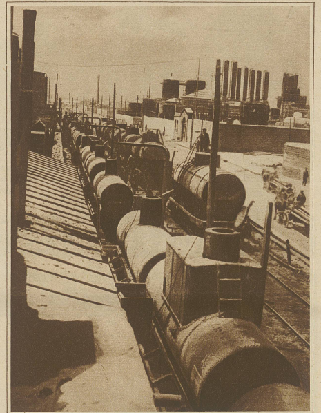
Blick auf eine große Petroleum-Destillationsanlage
