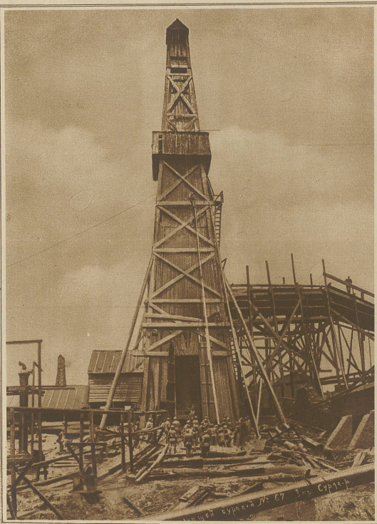
Ein Bohrturm, in dessen Innern die mit Brettern verkleidete Oelfontäne sichtbar ist
