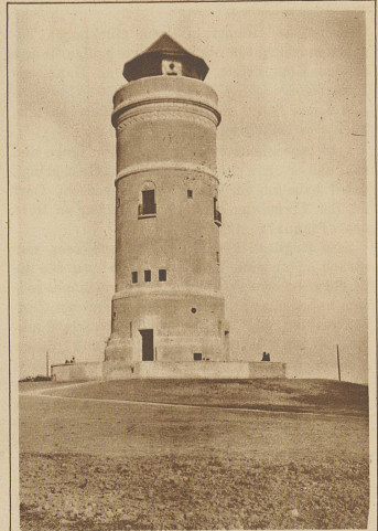
Ein «Luginland» der heutigen Zeit. Auf dem Bruderholz bei Basel wurde ein 45 Meter hoher Wasser- und Aussichtsturm erstellt
