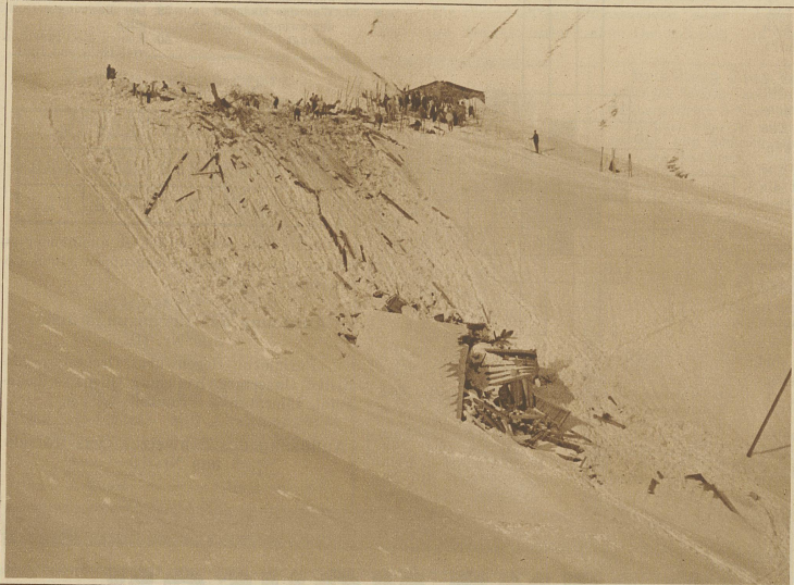
Anblick der Unglücksstelle während der Rettungsarbeiten. Im Vordergrund die Trümmer der vom Lawinendruck den Hang hinuntergeworlenen Hütte Phot. Funz, Davos
