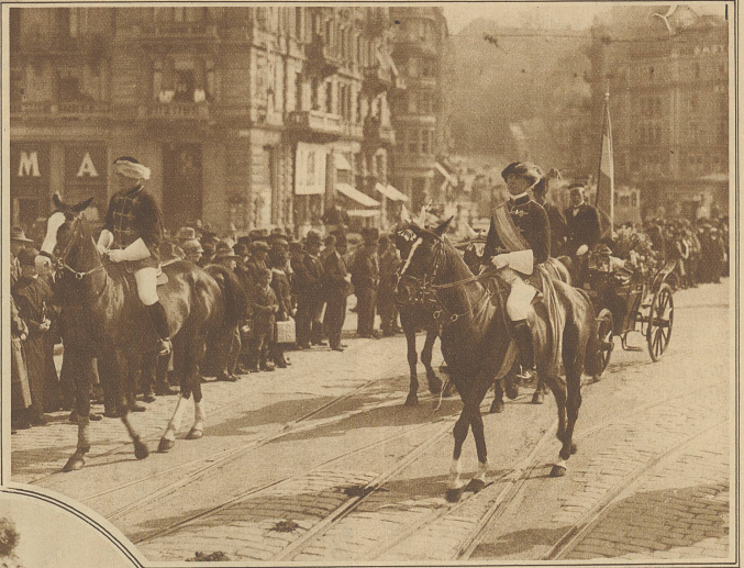
Der Aufzug auf der Quaibrücke
