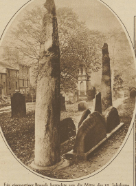
Ein romanischer Brunnen herrscht von der Höhe des 11. Jahrhunderts in der Gasse von Witten, wo der Versuch eines Umbaus von der Höhe einer Kränzelung gemacht wurde. Unter dem zwei hohen Steine, die auf eine noch erhebliche Größe der Verwitterung schließen lassen
