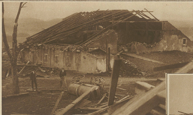
Zerstörtes Phot. Schneider
