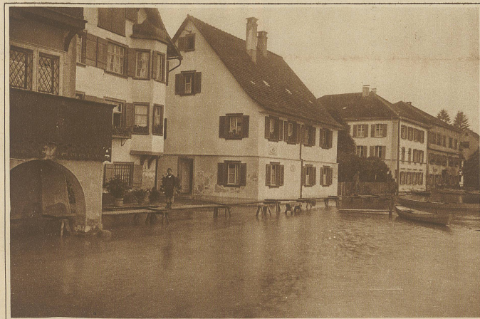
Hochwasser in Gottlieben
