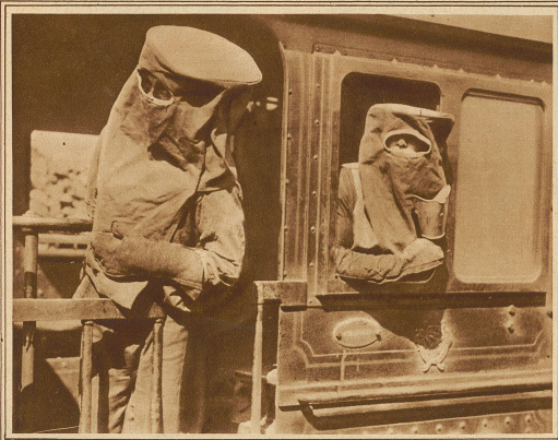
Sicherheitsmasken für Lokomotivführer. Ein australischer Ingenieur hat eine Maske für Lokomotivführer erfunden, die einen sichern Schutz gegen Gas- und Rauchvergiftungen bei Fahrten durch längere Tunnel mit starker Steigung gewährt
