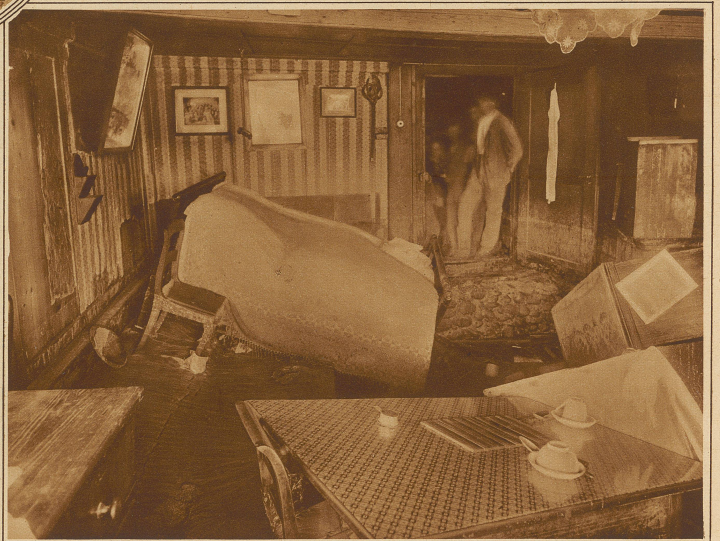
Eingestürzter Zimmerboden. Die Möbel schwimmen in Schlamm und Wasser
