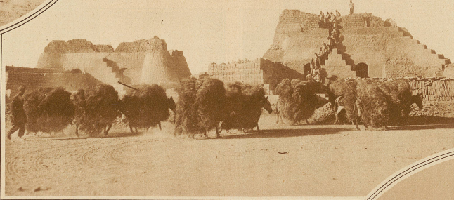
Gesamtansicht eines persischen Ziegelwerkes. Man arbeitet hier noch genau nach den gleichen Methoden, wie in der Bauzeit der großen Pyramiden
