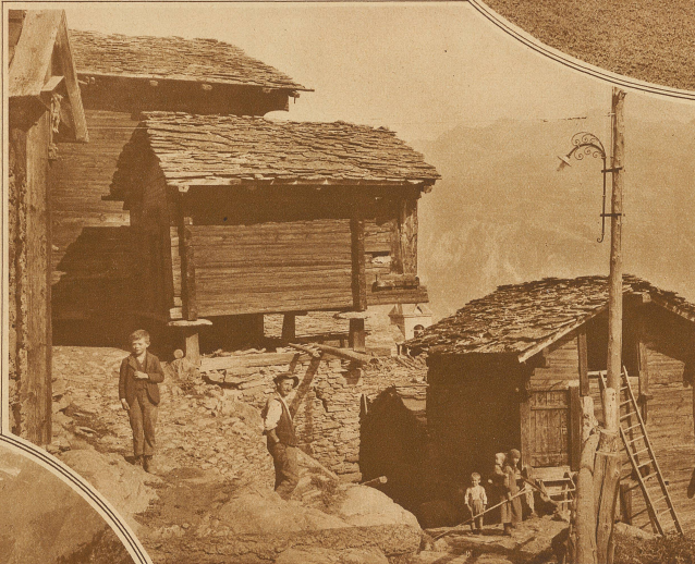
Die Speicher werden über die bekannten Gneisplatten gebaut, zum Schutze gegen Ratten und Mäuse
