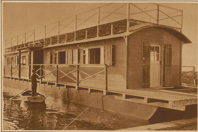
Das von einem Genfer Sportsmann gebaute schwimmende Haus, das eine Länge von 24 m hat und mit einem 18 P.S.-Motor versehen ist Phot. Guidoux
