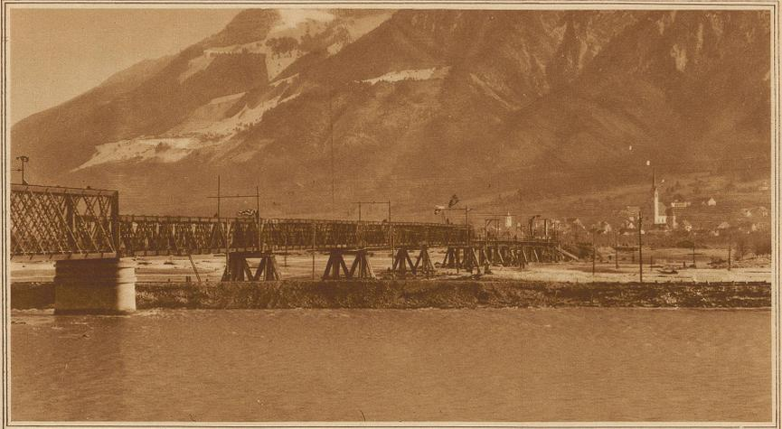
Am Donnerstag ist nun der Verkehr über die fertiggestellte provisorische Eisenbahnbrücke Buchs-Schaan wieder aufgenommen worden, nachdem vorher eine Belastungsprobe mit zwei schweizerischen Dampflokomotiven von 108 bzw. 198 Tonnen Dienstgewicht durchgeführt worden war. Das Bild zeigt die auf Holzapfeln ruhende provisorische Brücke
