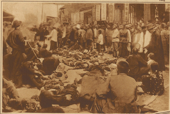
138 Tote bei einem Hauseinsturz in Shanghai. Anlässlich einer von 500 Frauen besuchten Versammlung im 5. Stock eines Kinos in Shanghai brach plötzlich die Decke durch und durchschlug die unteren Stockwerke. 138 Frauen wurden dabei getötet und 200 verletzt. Das Bild zeigt den schaurigen Anblick der Bergung der Opfer
