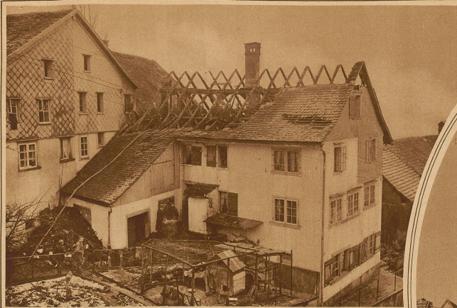
Brandunglück in Zollikon. In Zollikon wurde am Neujahrstag, früh um 4 Uhr, der Dachstuhl eines von drei Familien bewohnten Hauses durch Feuer zerstört. Der 41-jährige Schlosser Keller ist in den Flammen umgekommen
