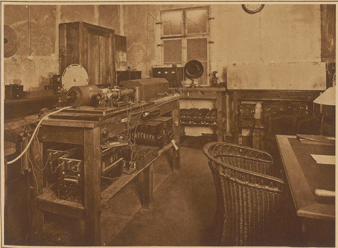
Blick in den Bildersenderaum der Station Nauen
