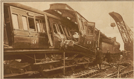
Auf dem Bahnhof in Hull (England) stießen zwei Personenzüge mit voller Fahrgeschwindigkeit aufeinander, wobei 11 Reisende getötet wurden. Unser Bild zeigt den einen der beiden Züge, dessen vorderste zwei Wagen vollständig ineinandergeschoben wurden
