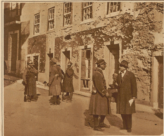
Ein mit Maschinengewehren beschossenes Haus in Lissabon
