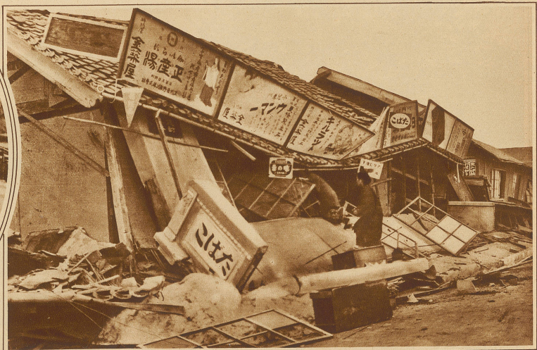
Eingestürzte Gebäude in Yamada
