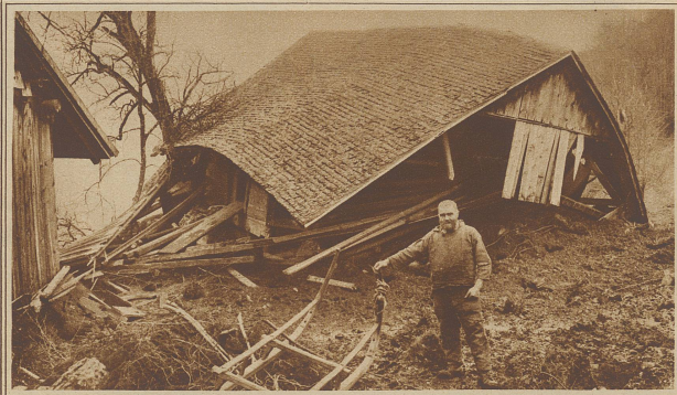
Erdschüttel. Letzter Tage ging in Tils (Sarganserland) ein Erdschüttel nieder. Haus und Stall des Martin Schlegel wurden demzufolge über Wannen und Hänge ins Seeetal hinunter mitgerissen. Frau Schlegel befand sich mit einigen Kindern in der Stube. Die Mutter und ein siebenjähriges Kind waren vom eindringenden Schlamm halb zugedeckt, während zwei kleinere Kinder zwischen zusammenstürzenden Holz gerieten, doch kamen alle sozusagen ohne Verletzungen davon. Der Eigentümer vor seinem zerstörten Hause. Links der Birnbaum, der das russische Haus aufhielt
