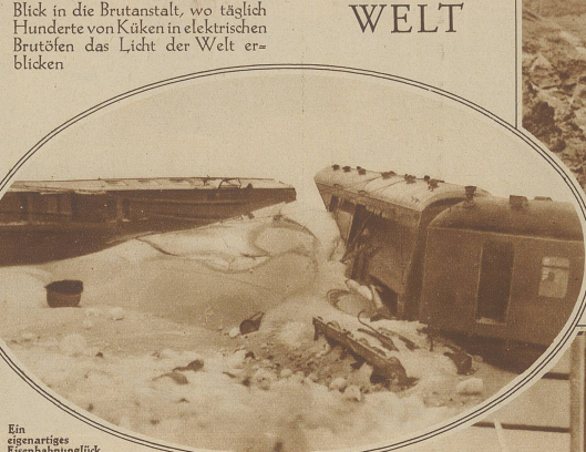
Ein eigenartiges Eisenbahnunglück ereignete sich in Amerika, etwa 50 km von Portland entfernt, wo ein Zug der Pacific Transcontinental Linie von einem Schneesturm überrascht und zum Entgleisen gebracht wurde. Trotzdem die Passagiere erst nach 3 Tagen gerettet werden konnten, fand nur eine Person den Tod
