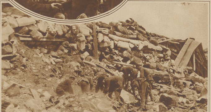
Der Trümmerhaufen der Volksbank in Tschirpan
