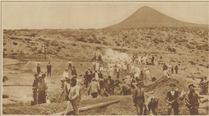
Arbeiter und Marinesoldaten werfen Dämme auf, um das umherfließende Petroleum zu sammeln
