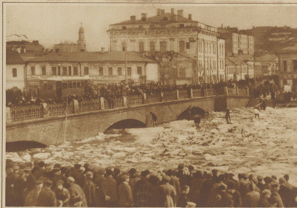
Moskau hat einen äußerst strengen Winter erlebt. Die meisten Kanäle waren meterdick zugefroren, so daß das nun eingetretene Tauwetter einen gefährlichen Eingang der Flüsse besorgt. Das Bild zeigt Arbeiter an der Arbeit vor einer gefährdeten Brücke
