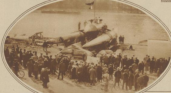
Der Ozeano-Gliseur ist das neueste Vehikel, mit welchem die Überquerung des Ozeans im nächsten Monat versucht werden soll. Wie das Bild zeigt, handelt es sich um ein Climbcoo, das außer mit Schrauben auch mit Luftpropellern angetrieben wird. Man rechnet mit einer durchschnittlichen Geschwindigkeit von gegen 100 km
