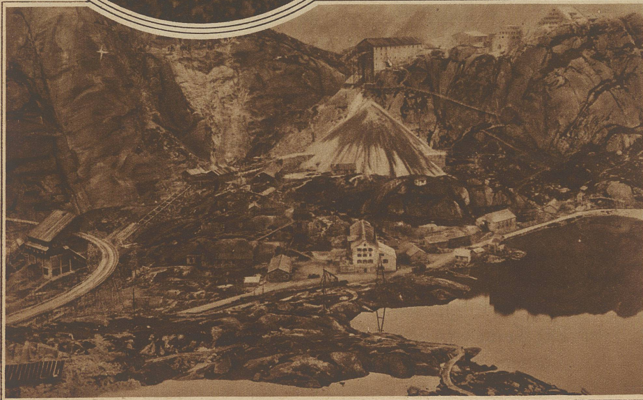
Titaneuwerk im Grimselgranit. Durch einen massiven Dam quer über die Aarlammschleuse wird das Gebiet des Unteraarbodens und der beiden Grimselseen überstaut; das alte Grimselhospital im Vordergrund muß geopfert werden, denn der Stauseespiegel erreicht die Höhe des links sichtbaren Kreuzes. Rechts auf dem «Nollen» das neue Hospital (Phot. Bürgli)
