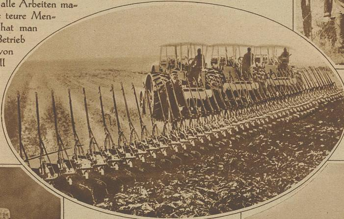
Umackern eines Feldes mit einem gewaltigen Motorpflug von 50 Pflugscharen. Auf diese Weise kann ein 15 Meter breiter Streifen auf einmal umgefahren werden
