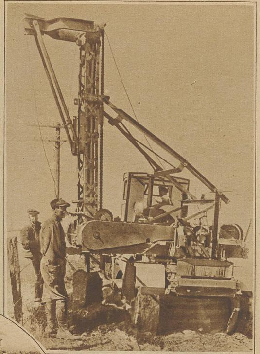
Die Maschine bohrt das Loch
