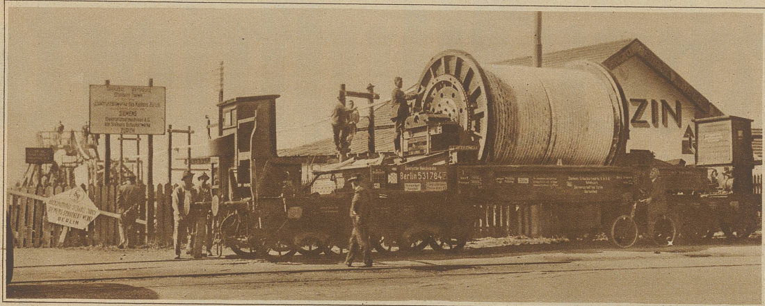
Die Kabel wurden im Bahnhof Tiefenbrunnen auf ein Schiff verladen
