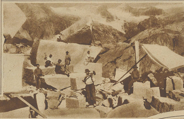
Der gesunde Grimselgranit liefert an Ort und Stelle das Material für die Mauerkrone und den Wasserüberfall der Gelmersperr
