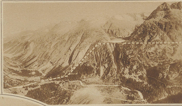
Das Wasser wird vom Grimselsee durch einen 5,2 km langen Verbindungsstollen zum Gelmersee geleitet, von wo die erste Druckleitung hinab in die Zentrale Handeck führt
