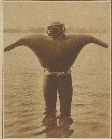
Ein neuer Rettungsanzug für Schiffbrüchige, der wie ein vorsintflutliches Seeungeheuer anmutet. Er enthält innen luftgefüllte Zellen, die den Schiffbrüchigen über Wasser halten. Da der Anzug auch Lebensmittel faßt, kann man es darin etwa 8 Tage aushalten
