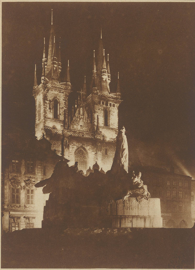
Das Denkmal des tschechischen Reformators Hus
