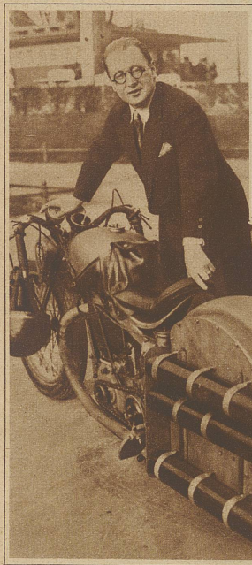
Das erste Raketentorrad, das auf der Rüsselsheimer Bahn ausprobiert wurde
