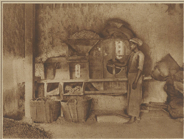
Wie bei uns das Korn, werden die Erdnüsse auf der Windfège gereinigt, bevor sie geschält und gemahlen werden
