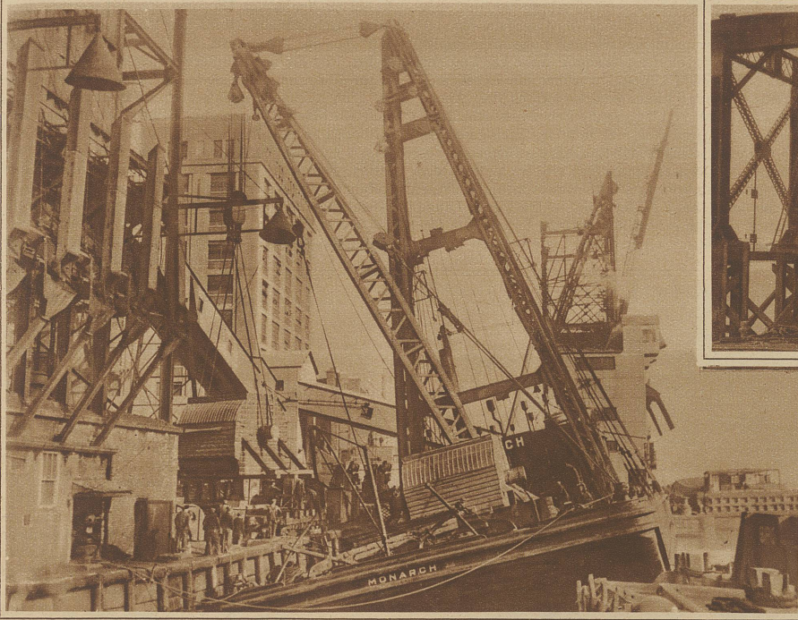
Der größte Schwimmkran ist im Hafen von New York zu sehen, wo damit kürzlich zwei Generatoren im Gewicht von je 113 000 kg ausgeladen wurden. Im Bilde hängt eine der Kästen schon über dem Kai; der Schwimmkran neigt infolge des großen Gewichts stark zur Seite
