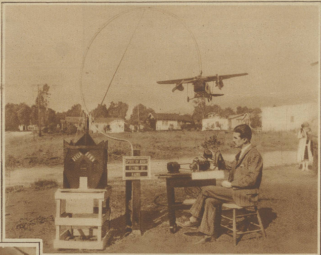
Flugzeuglenkung durch Radio. Der junge amerikanische Erfinder Maurice Poiriera aus Kalifornien hat ein Miniaturflugzeug konstruiert, das er mit einem Radioapparat ferndirigiert. Das Flugzeug ist das Modell eines dreimotorigen Eindeckers
