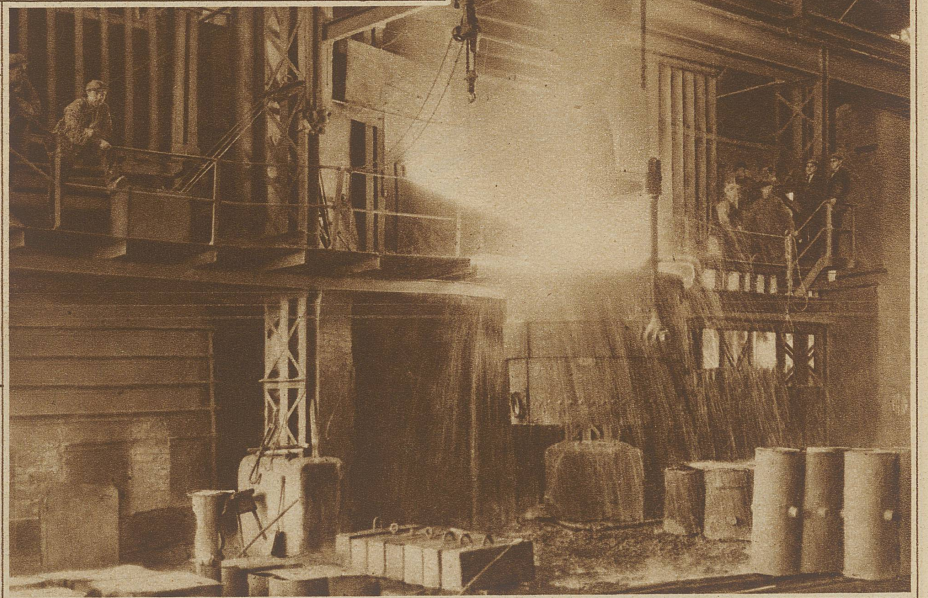
Gießen des Stahls
